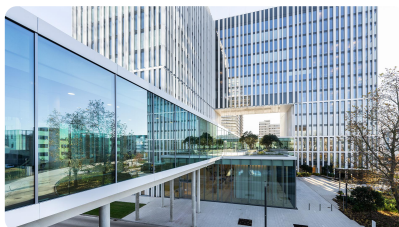
Dafür haben die Koblenzer die auf Sachwertinvestments spezia
