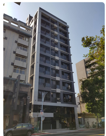
臺北市府全球資訊網-市府新聞稿-臺北市首件危老重建工程使照核准
